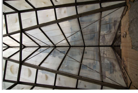
Fotografie skleněné koruny dokumentují stávající stav, tvořený nosnou ocelovou konstrukci sestavenou z pásoviny a U profilů a jejich lemovacích profilů, které rámuji tvarované skleněné vípnlě.
